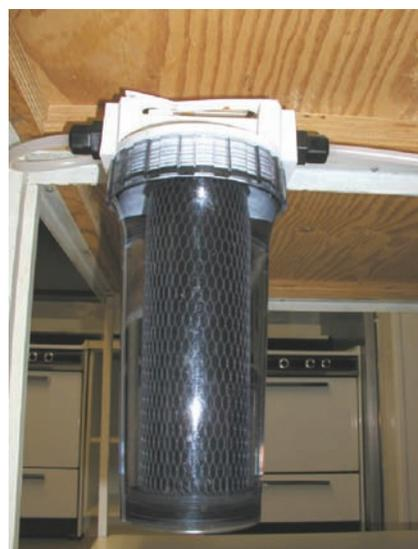
Figura-4. Filtro de carvão ativado no laboratório no 1: local impróprio e ausência de sistema de pré-filtração.
