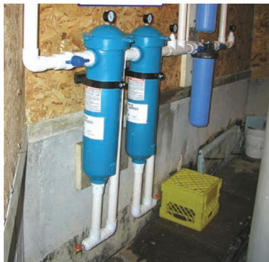
Figura-3. Sistema de purificação de água no laboratório no 3: local impróprio e ausência de manutenção preventiva e controle dos filtros.
